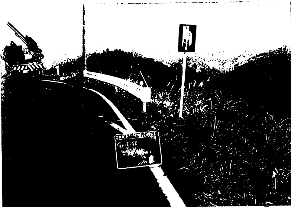
完成 ガードレール設置工 Gr-C-4E
