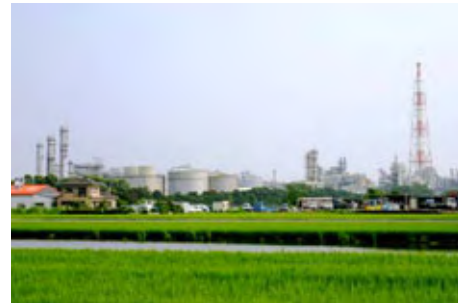
長浜町の工場
