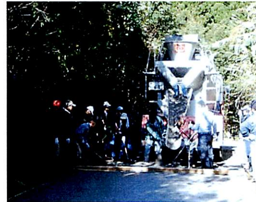
コンクリート舗装
