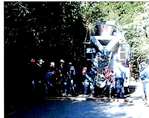
コンクリート舗装
