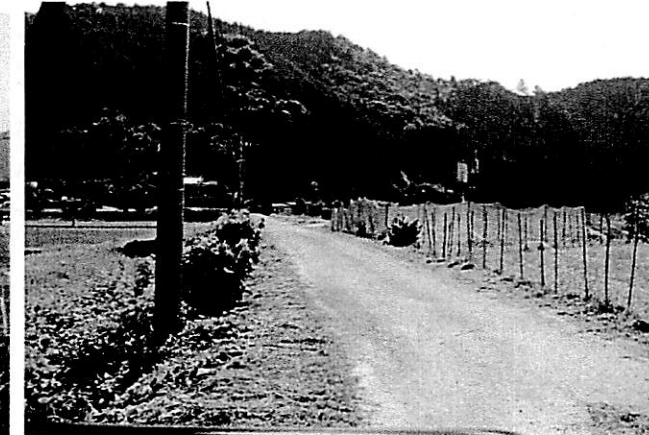
作業後の写真
