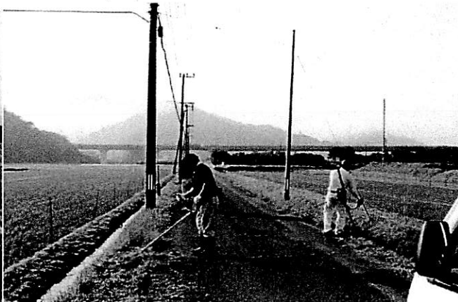
作業中の写真
