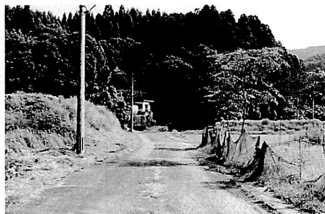
作業後の写真
