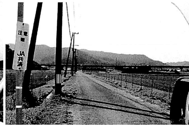
作業後の写真
