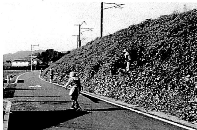
作業後の写真
